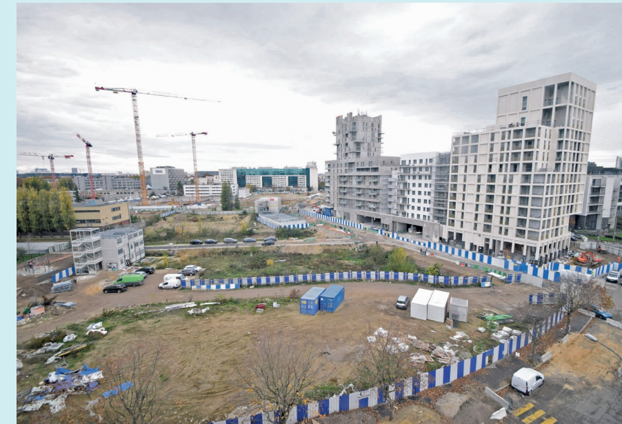
Vue aérienne du lot A3-A4 en décembre 2020
